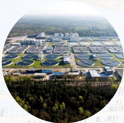
Oczyszczalnia ścieków Czajka w Warszawie
